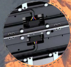
Koblingen mellom kabinett
